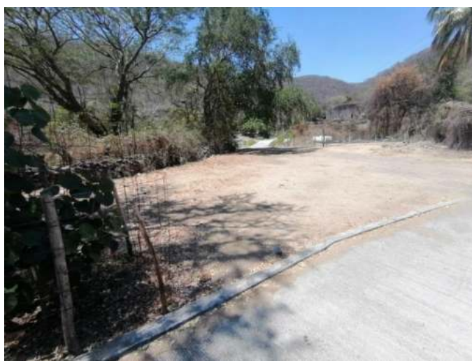
Ilustración 7. Predio y poste de luz para funcionamiento del sistema de purificación.
