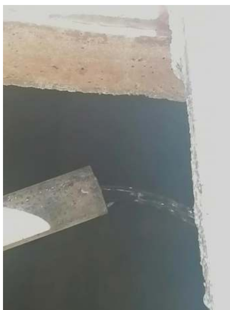
Ilustración 5. Manantial, cisterna, llenado de cisterna.
