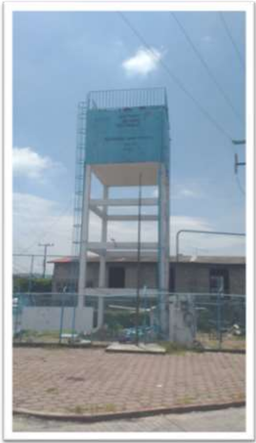
Figura 5. Sistema de agua Lázaro Cárdenas, Jiutepec, Morelos
